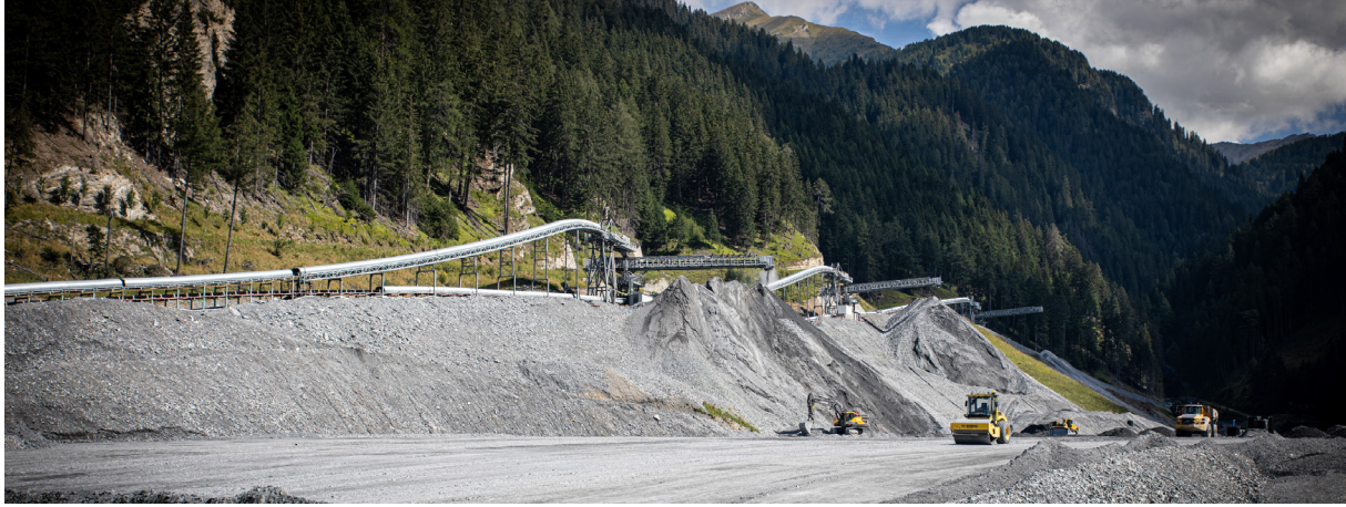
Das Ausbruchsmaterial kommt in die Deponie Padastertal
