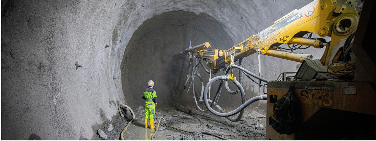
Sprengvortrieb im Erkundungsstollen
