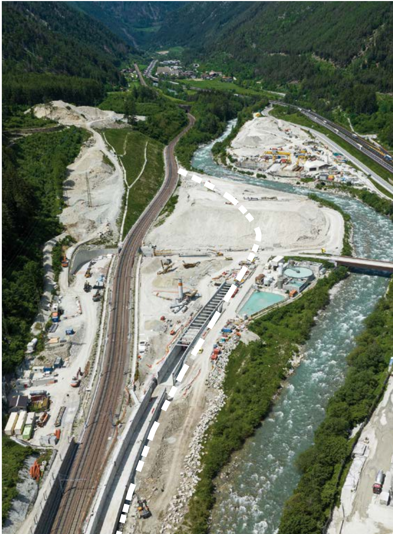
Area di cantiere - la linea bianca evidenzia il vecchio tracciato della ferrovia regionale. Baustellenbereich - die weiße Linie markiert die alte Trasse der Regionalbahn.
