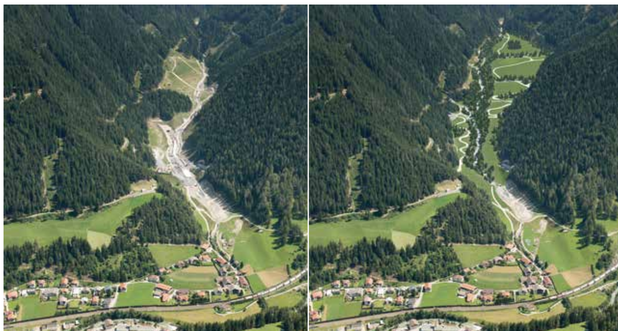
Padastertal 2014: Die Baumaßnahmen (Schutterstollen, Rückhaltebecken etc.) sind abgeschlossen, die Deponierung des Ausbruchsmaterials läuft.
