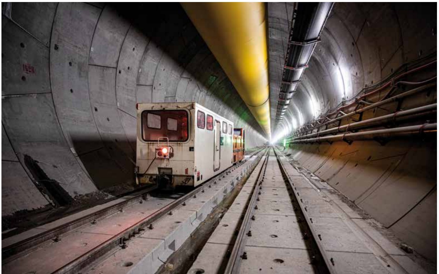
Versorgungszug im Baulos Mault 2-3
