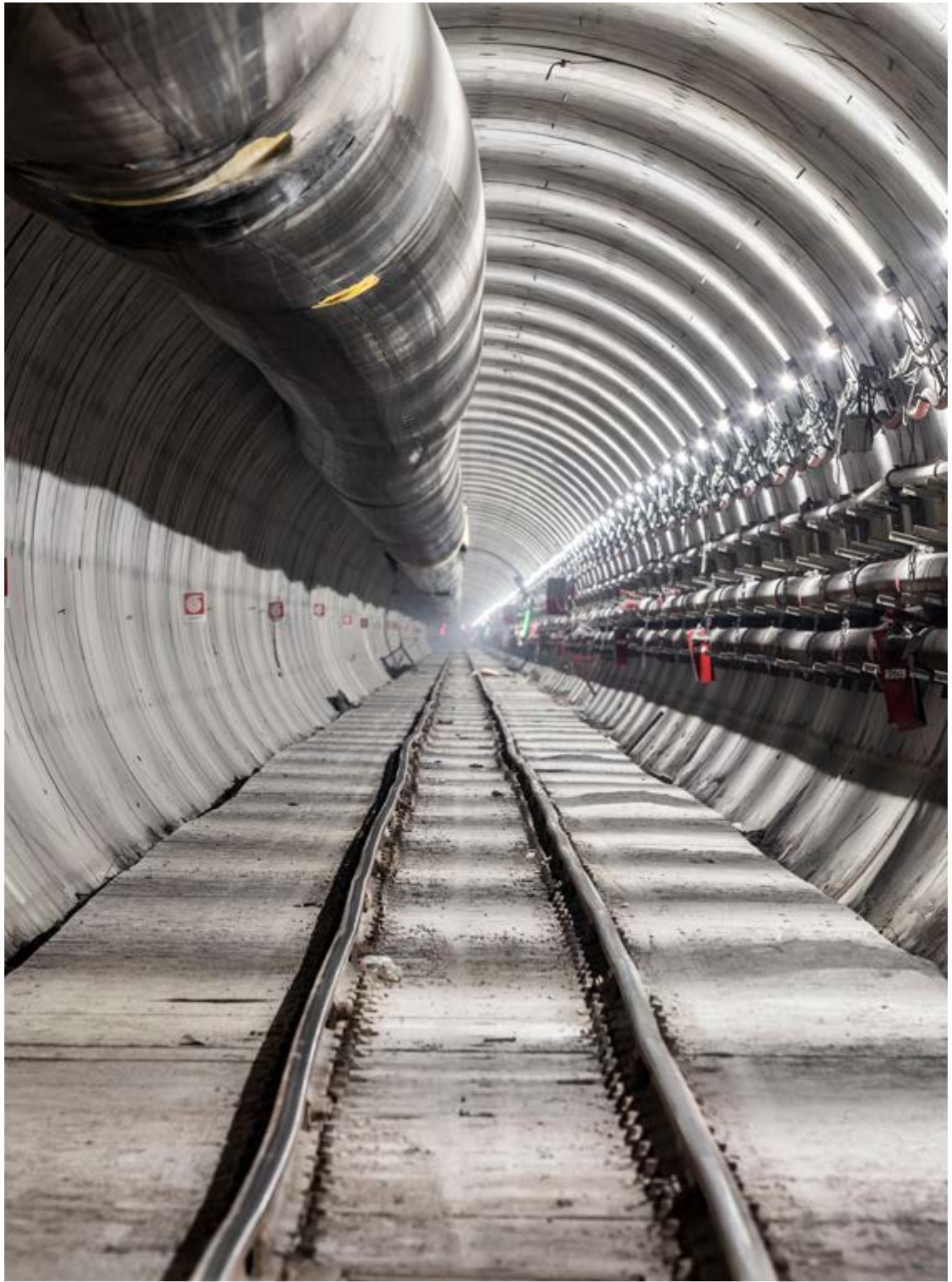
Il cunicolo esplorativo è già stato scavato fino al confine del Brennero. Der Erkundungsstollen ist bereits bis zur Brennergrenze ausgebrochen.
