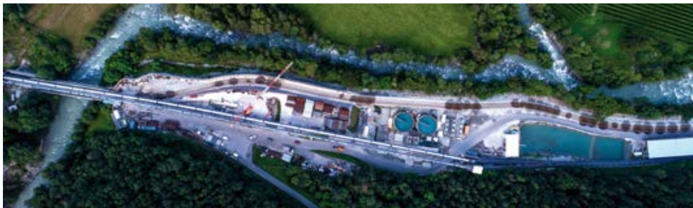
Impianto di depurazione acque ad Unterplattner presso l'imbocco sud del cunicolo esplorativo Wasseraufbereitungsanlage Unterplattner beim Südportal des Erkundungstollens
