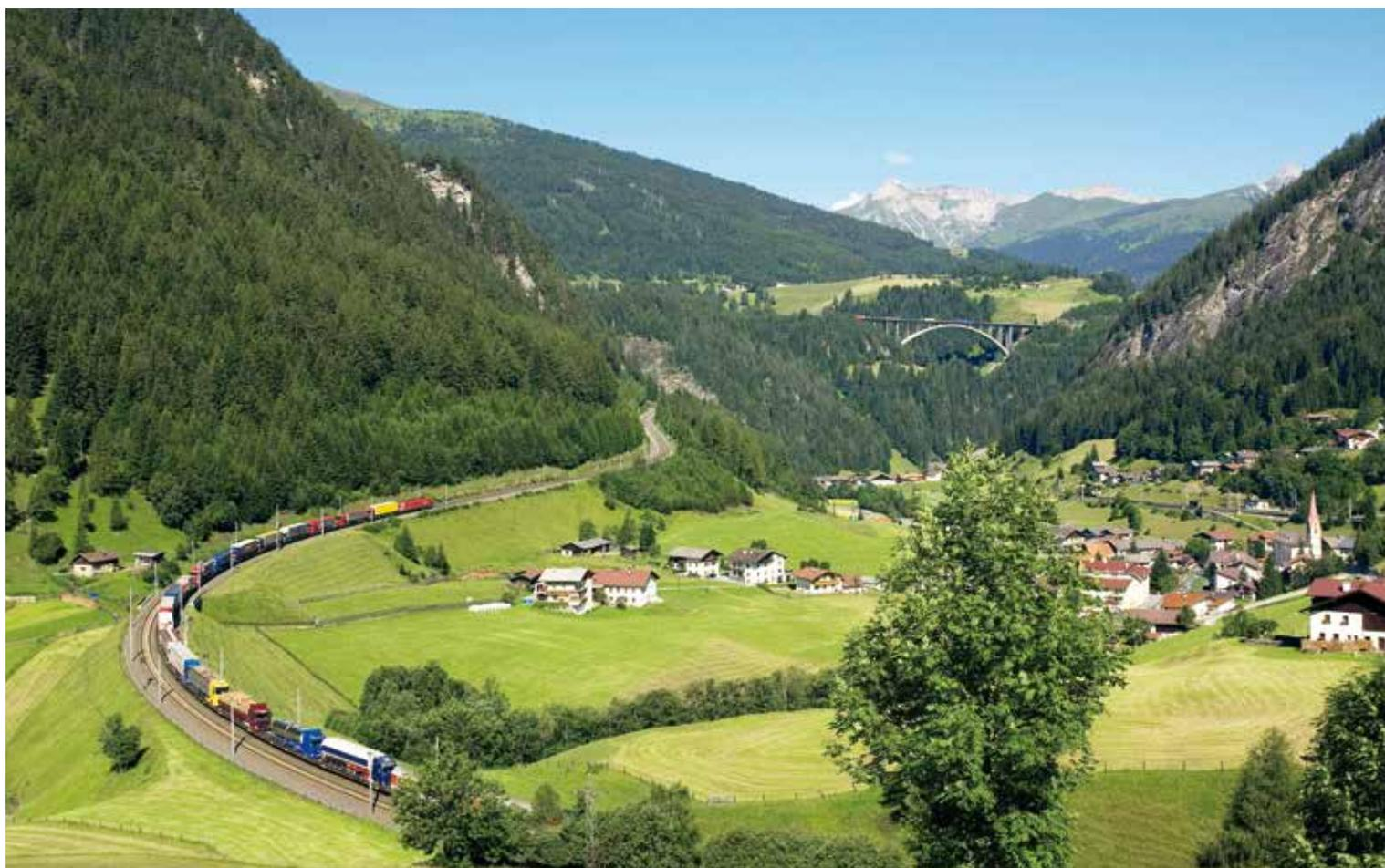
Un treno "dell'autostrada viaggiante" presso St. Jodok am Brenner. I treni guadagnano quota in un grande tornante intorno al paese nonché in una galleria elicoidale lunga 481 metri. L'immagine illustra la salita ripida lungo la rampa nord del Brennero.
