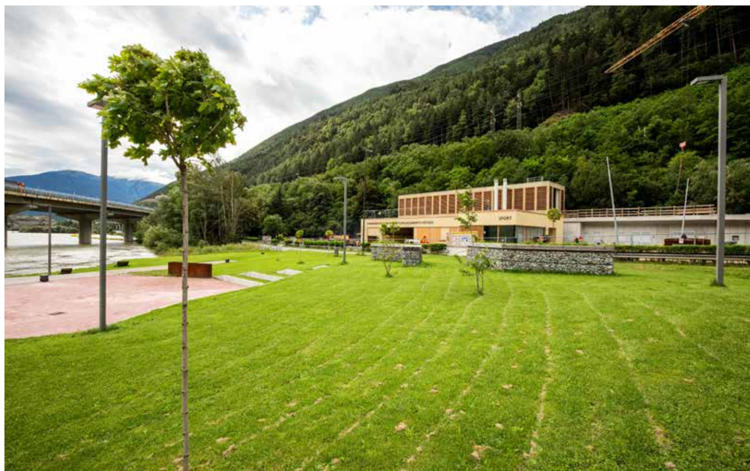
Nuovo impianto di teleriscaldamento a Fortezza Neu errichtetes Fernheizwerk in Franzensfeste
