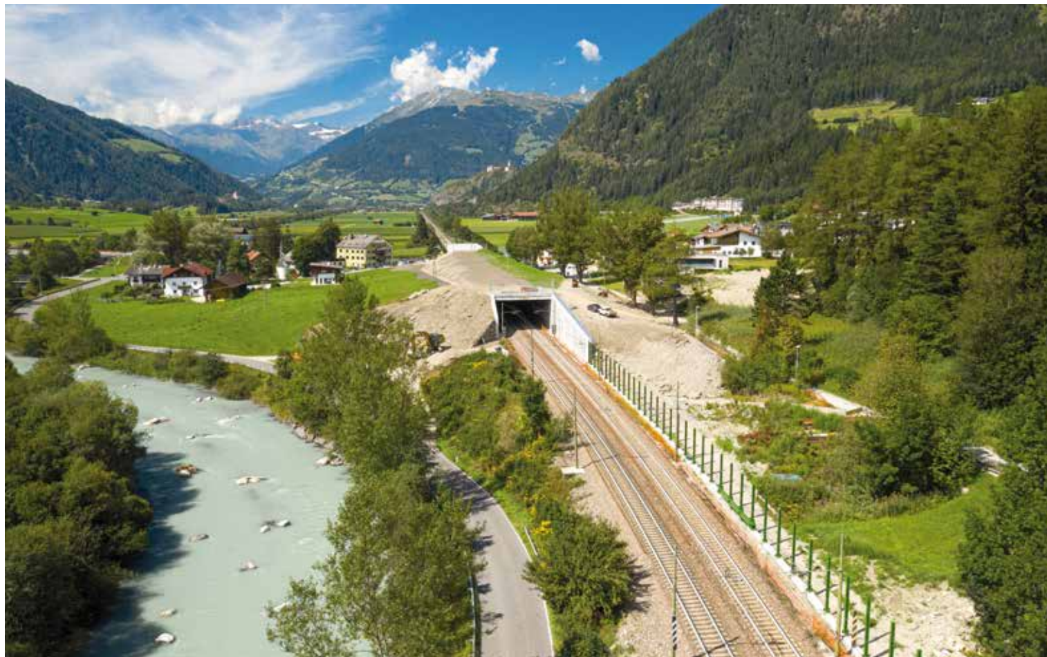
Copertura della linea ferroviaria del Brennero a Campo di Trens Einhausung der Brennerbahn in der Ortschaft Freienfeld
